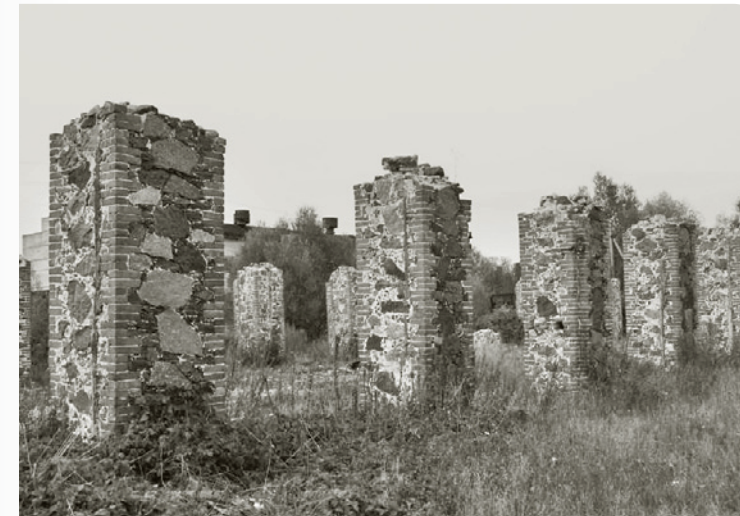
Kluono akmens ir plytų mūro karkasas. Liberiškio k. Panevėžio r.
