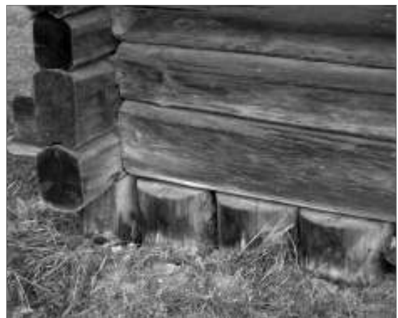
Kluono, atkelto iš Barčių k. Varėnos r., medinių trinkų pamatai [LLBM]
