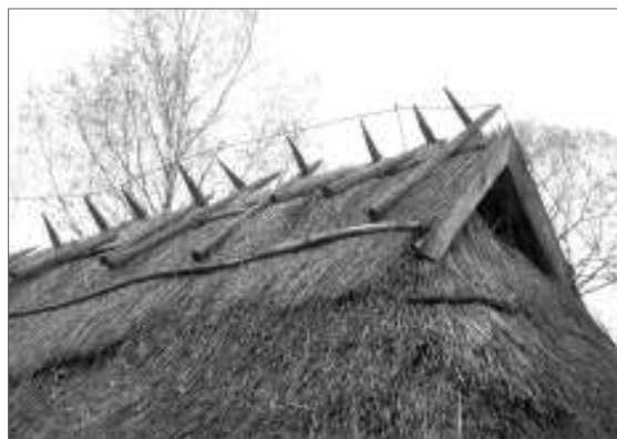
Tvarto, atkelto iš Beviršių k. Lazdijų r., šiaudinis stogas su sluogčiais [LLBM]
