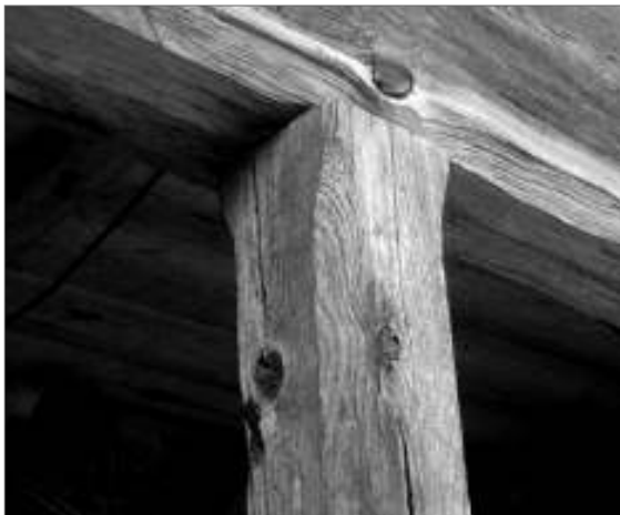
Nežymiai nusklembtos priesvirnio kolonėlės jungtis su sija Šukiškių k. Vilniaus r. [A. Andriušytės 2007 m. nuotr.]
