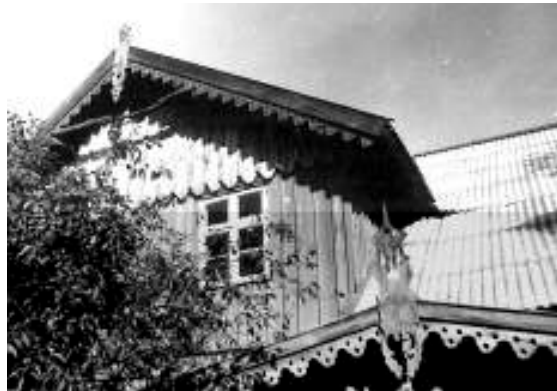
XX a. pr. būdingo gyvenamojo namo – vilos Rusnės apylinkėse puošmenos: drožinėtos vėjalentės ir lėkia, stogo skydo apkalimo lentų apačia, šoninė kryžminė mansarda, gonkelis – prieangis // Martyno Purvino nuotr. (1987 m.)
