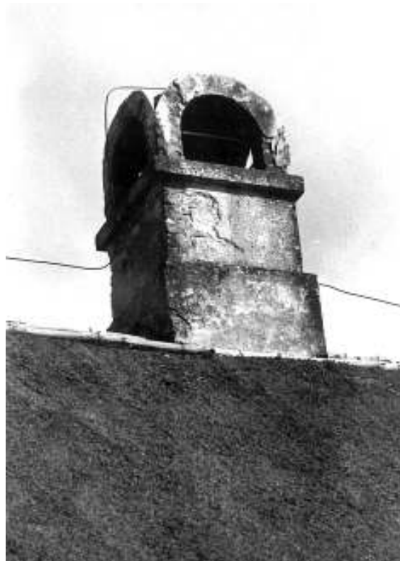
XVIII–XIX a. būdingo lietuvininkų namo iš Priekulės apylinkių, dabar Olsztyneko (Lenkija) „Muzeum budownictwa ludowego“ (pervežtas iš Rytprūsių tėviškės muziejaus Karaliaučiuje), būdingas dūmtraukio stogelis // Martyno Purvino nuotr. (1999 m.)
