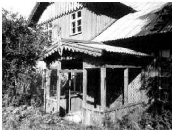
XX a. pr. būdingas namas – vila Rusnės apylinkėse – atviras medinis gonkelis, šoninė mansarda, drožinėtos medinės puošmenos // Martyno Purvino nuotr. (1987 m.)
