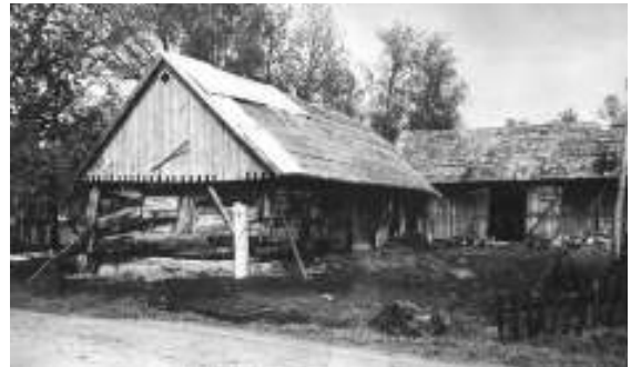
Pelkininkų sodybėlė Žalgirių kaime Šilutės apylinkėse. XX a. pr. būdingas medinis tvartas (kairėje) ir daržinė (dešinėje), dengti nendrėmis // Martyno Purvino nuotr. (1995 m.)
