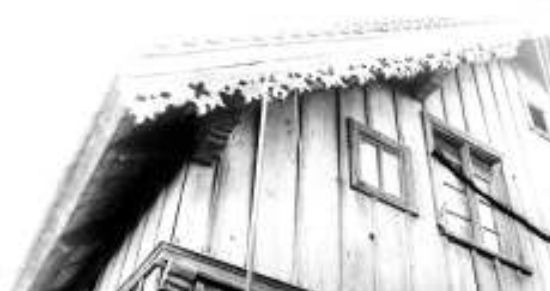
XX a. pr. būdingo gyvenamojo namo Pagėgių apylinkėse puošmenos: stačiomis lentomis ir profiliuotais tašeliais apkaltos sienos, drožinėti išorėn išsikišusių sijų galai, profiliuota lenta atskirta ertikio (pastogės) dalis, sudėtingo piešinio drožinėtos medinės vėjalentės // Martyno Purvino nuotr. (1991 m.)
