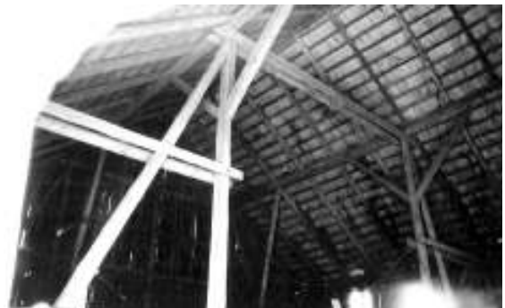
XX a. pirmajai pusei būdinga didžioji daržinė Šilutės apylinkėse – medinė rėminė konstrukcija, išorėje apkalta stačiomis lentomis // Martyno Purvino nuotr. (1994 m.)
