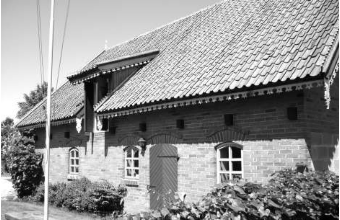
Pagal senus pavyzdžius atstatytas kraštui būdingas raudonplytis paupio tvartas Minijos (Mingės) kaime Šilutės r. Atstatant buvo padidintos langų angos, įdėti dabartinei pastato paskirčiai tinkamesni langeliai. Pastatas buvo papildomai padailintas, įrengtos regionui būdingos medinės puošmenos, dailinės durys ir pan. // Martyno Purvino nuotr. (2008 m. liepos mėn.)
