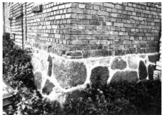
XX a. pr. būdingas iš skeltų akmenų mūrytas pamatas pasiturinčio ūkininko sodyboje Saugų apylinkėse // Martyno Purvino nuotr. (1995 m.)
