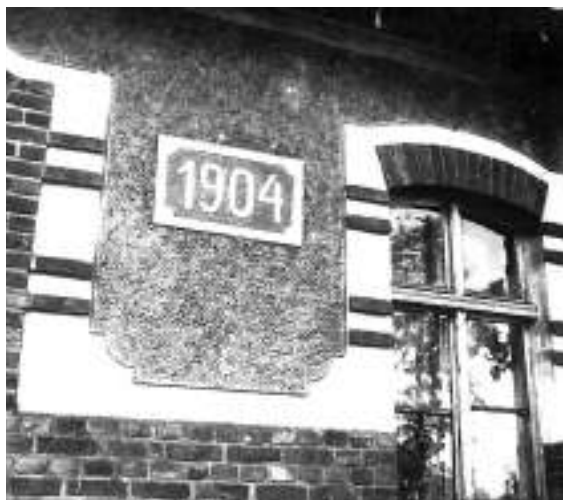
1904 m. statytas puošniai dekoruotas mūrinis pastatas Pagėgių apylinkėse – įvairaus atspalvio ir faktūros tinko, raudonų plytų intarpų deriniai, medinės drožinės vėjalentės // Martyno Purvino nuotr. (1992 m.)
