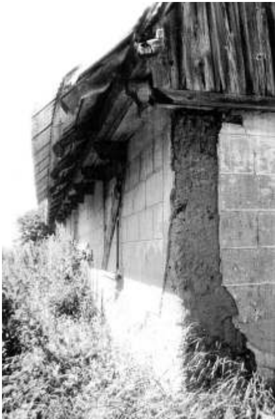
XIX a. pab. – XX a. pr. būdingas molinis namas Priekulės apylinkėse: tinkuotos sienos puoštos rustika, drožinėti mediniai pastogės elementai // Martyno Purvino nuotr. (1992 m.)
