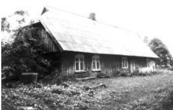
XVIII–XIX a. būdingas Nemuno deltos žvejų medinis gyvenamasis namas Rusnės apylinkėse – žemos sienos, apkaltos stačiomis lentomis, aukštas laužytos čiukurinės formos stogas, dekoratyviniai sandriukai virš langų // Martyno Purvino nuotr. (1992 m.)
