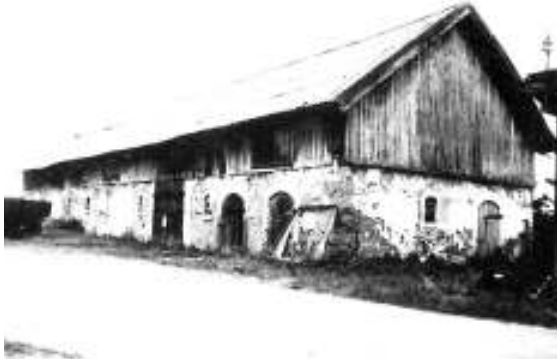
XIX a. pab. – XX a. pr. būdingas vidutinio ūkininko molinis tvartas su mediniu ertikiu Saugų apylinkėse – mūriniai apvadai aplink angas, tinkuotos ir baltintos sienos, ertikyje – pastogėje įrengta šieninė // Martyno Purvino nuotr. (1996 m.)
