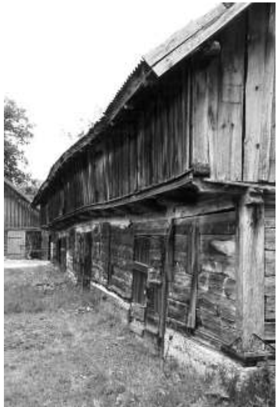
XX a. pr. būdingas stambesnio ūkininko medinis ūkinis pastatas Priekulės apylinkėse – išorėn iškištas ertikis, šulų – blankių konstrukcijos medinės sienos, betoniniai pamatai, daugelis durų į gausias patalpas // Martyno Purvino nuotr. (2004 m.)
