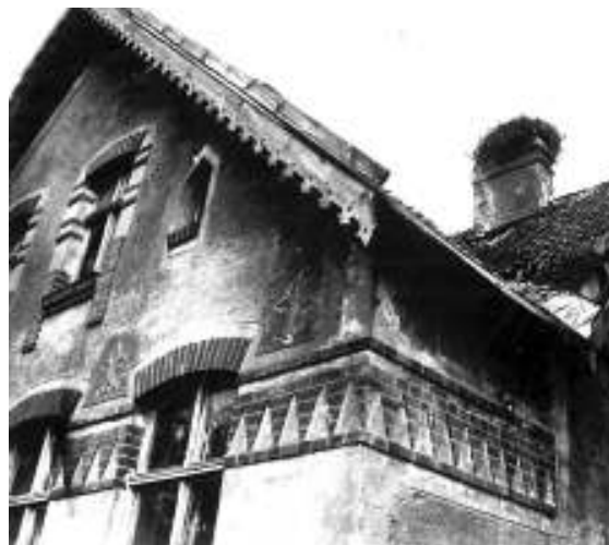
1904 m. statytas puošniai dekoruotas mūrinis pastatas Pagėgių apylinkėse – įvairaus atspalvio ir faktūros tinko, raudonų plytų intarpų deriniai, medinės drožinės vėjalentės // Martyno Purvino nuotr. (1992 m.)
