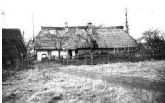
XVIII a. būdingas medinis lietuvininkų gyvenamasis namas Saugų apylinkėse – gerasis galas išorėje baltintas, šiaudais dengtas stogas laužytos čiukurinės formos, stogo skydas apkaltas įstrižomis lentomis, sienos žemos, langeliai maži // Martyno Purvino nuotr. (1996 m.)
