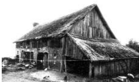
XIX a. pab. – XX a. pr. būdingas stambesnio vidutinio ūkininko raudonplytis tvartas Kintų apylinkėse – medinis ertikis, malkinės – vežiminės priestatas, nendrėmis dengtas stogas, dekoruota ertikio apkalimo lentų apačia // Martyno Purvino nuotr. (1992 m.)
