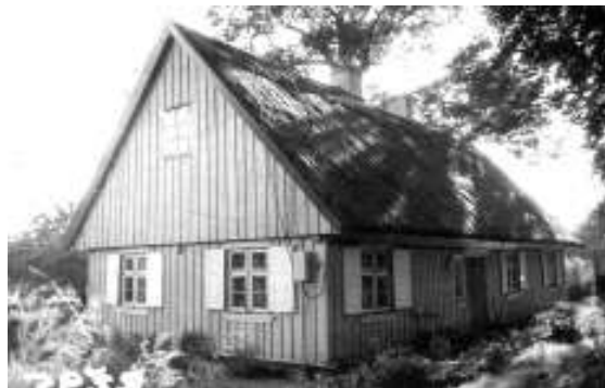
XX a. pr. būdingas Nemuno deltos žvejų gyvenamasis namas Rusnės apylinkėse – stačiomis lentomis apkaltos medinės sienos, aukštas nendrėmis dengtas stogas, langinėmis uždengiami nedideli langai // Martyno Purvino nuotr. (1987 m.)
