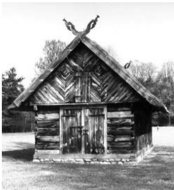
XIX a. būdingas medinis pamaro žvejų ūkinis pastatėlis iš Gillijos kaimo Olsztyneko (Lenkija) „Muzeum budownictwa ludowego“ (ten pervežtas iš Rytprūsijų tėviškės muziejaus Karaliaučiuje) – medinių sienojų rėstos sienos, nendrėmis dengtas stogas, jo skydo dekoratyvinis apkalimas, puošnūs žirgeliai stogo kraige // Martyno Purvino nuotr. (1999 m.)
