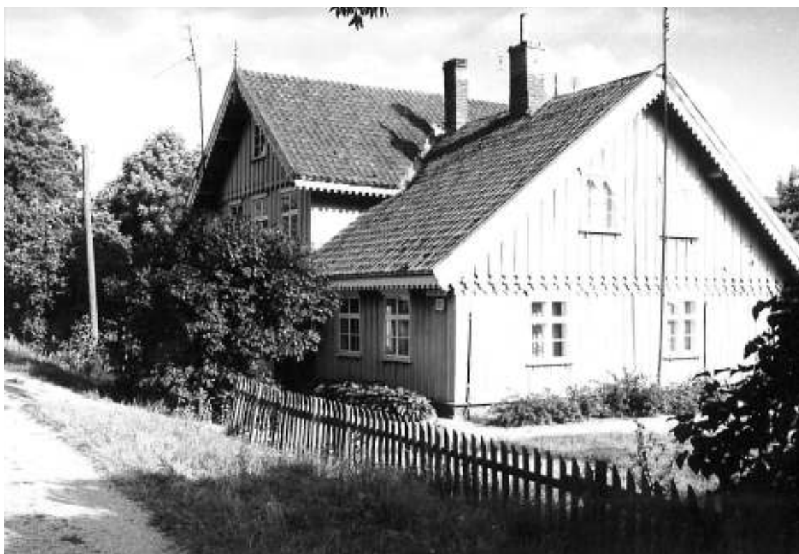
XX a. pr. būdingas pasiturinčio žvejo ir daržininko puošnūs medinis gyvenamasis namas Rusnės apylinkėse – šoninė kryžminė mansarda, raudonomis keraminėmis čerpėmis dengtas stogas, gausios medinės puošmenos (dekoruota stogo skydų apkalimo lentų apačia, drožinėtos vėjalentės, lėkiai ir kt.) // Martyno Purvino nuotr. (1998 m.)
