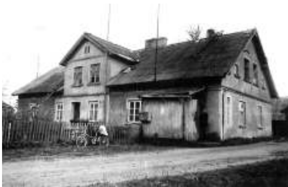
XX a. pr. būdingas 1917 m. statytas pasiturinčio ūkininko tinkuotas gyvenamasis namas Pagėgių apylinkėse – ertikis, šoninė kryžminė mansarda // Martyno Purvino nuotr. (1991 m.)
