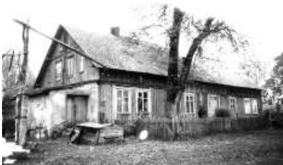
XX a. pr. būdingas ilgasis medinis gyvenamasis namas Šilutės apylinkėse – ertikis (paaukštinta pastogė) su įrengtomis gyvenamosiomis patalpomis, didesni langai // Martyno Purvino nuotr. (1996 m.)
