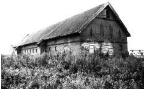
XX a. pirmajai pusei būdingas iš raudonų plytų sumūrytas stambaus ūkininko tvartas Lauksargių apylinkėse – dekoruotas ertikis ir stogo skydai, raudonų keraminių čerpių stogas, erdvi pastogė – šieninė su įvairiais techniniais įrenginiais // Martyno Purvino nuotr. (1998 m.)
