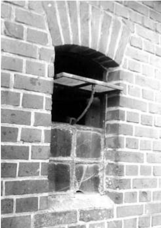
Mūrinis tvartas Rusnės apylinkėse – XIX a. paplitę metaliniai varstomi langų rėmai // Martyno Purvino nuotr. (1987 m.)
