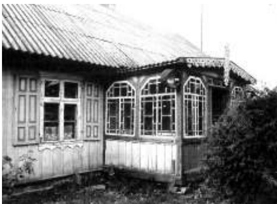
XX a. pr. būdingo gyvenamojo namo Šilutės apylinkėse puošmenos: stačiomis lentomis ir tašeliais apkaltos sienos, padailinti langų apvadai, įsprūdinės langinės, puošnus įstiklintas gonkelis – prieangis // Martyno Purvino nuotr. (1993 m.)
