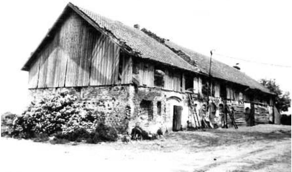
XIX a. pab. – XX a. pr. pasiturintiems pievininkams būdingas ilgas mūrinis tvartas Plaškių apylinkėse su mediniu ertikiu – šienine pastogėje, raudonomis keraminėmis čerpėmis dengtu stogu // Martyno Purvino nuotr. (1992 m.)
