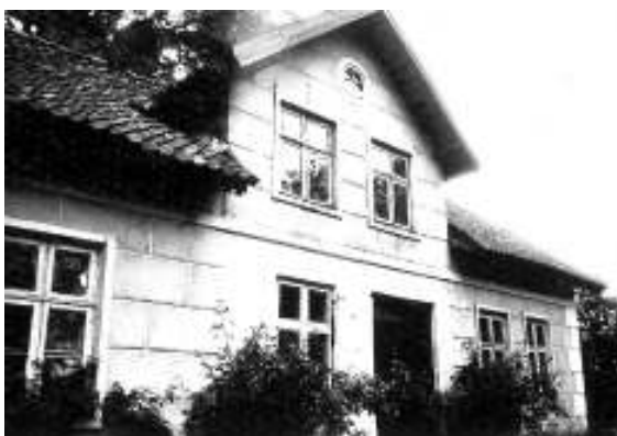
XX a. pradžioje pagal miestelių pavyzdžius statytas mūrinis ūkininko gyvenamasis namas Šilutės apylinkėse – šoninė kryžminė mansarda, rustuotos (akmens mūrą imituojančios) tinkuotos sienos, dideli langai, aukštos sienos, keraminių čerpių stogas // Martyno Purvino nuotr. (1994 m.)
