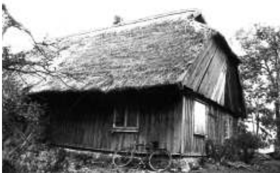
XVIII–XIX a. būdingas pievininkų gyvenamasis namas Ventės apylinkėse – medinės sienos, apkaltos stačiomis lentomis, nendrėmis dengtas laužytos čiukurinės formos stogas, įstrižai apkaltas stogo skydas, aukštesni pamatai // Martyno Purvino nuotr. (1992 m.)
