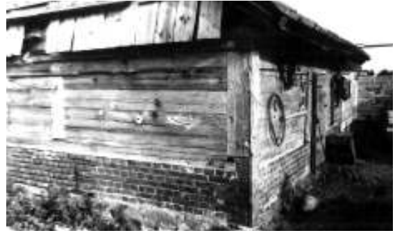
XX a. pr. būdingas ūkinis pastatėlis Rusnės apylinkėse – iš lauko akmenų sumūryti pamatai, virš jų iš raudonų plytų sumūrytas cokolis – pamatų paaukštinimas, aukščiau – šulų ir blankių konstrukcijos medinės sienos // Martyno Purvino nuotr. (1987 m.)
