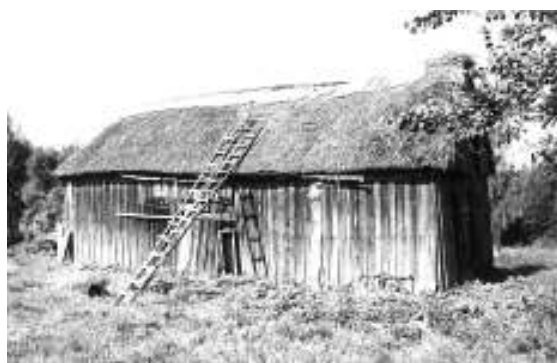
XX a. pr. būdinga medinė pelkininkų daržinė Kintų apylinkėse – paaukštintas nedidelio pastato tūris, nendrėmis dengtas stogas, stačiomis lentomis apkaltos sienos // Martyno Purvino nuotr. (1992 m.)
