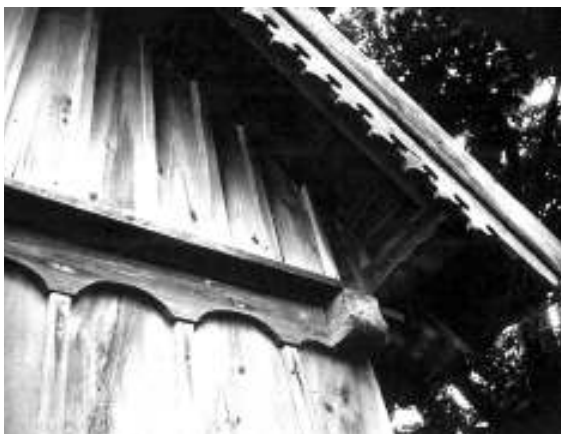
XX a. pr. būdingas medinis namas Šilutės apylinkėse – drožinėtos vėjalentės, būdingi sienų apkalimo elementai // Martyno Purvino nuotr. (1994 m.)
