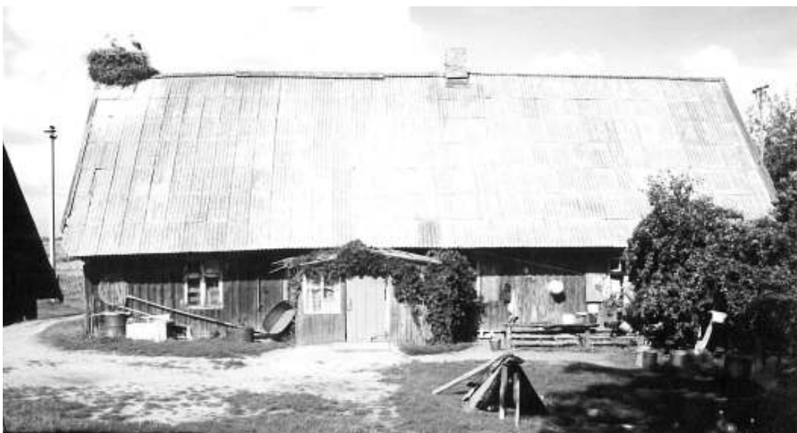
XIX a. – XX a. pr. būdingas Nemuno deltos žvejų gyvenamasis namas Rusnės apylinkėse – aukštas stogas, stačiomis lentomis apkaltos medinės sienos, nedidelis gonkelis – prieangis, neaukštos sienos // Martyno Purvino nuotr. (1998 m.)
