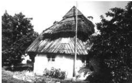
XVIII a. būdingas medinis lietuvininkų gyvenamasis namas Saugų apylinkėse – gerasis galas išorėje baltintas, šiaudais dengtas stogas laužytos čiukurinės formos, stogo skydas apkaltas įstrižomis lentomis, sienos žemos, langeliai maži // Martyno Purvino nuotr. (1996 m.)
