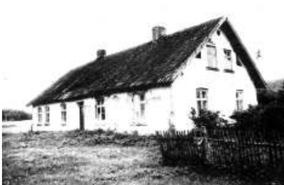
XIX a. būdingas ūkininko molinis gyvenamasis namas Saugų apylinkėse – raudonų keraminių čerpių stogas, tinkuotos ir baltintos sienos, iš raudonų plytų išmūrytos palangės // Martyno Purvino nuotr. (1996 m.)
