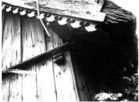
XIX a. būdingas medinis namas Ventės apylinkėse – drožinėtos vėjalentės, dekoruoti sijų ir gegnių galai // Martyno Purvino nuotr. (1992 m.)
