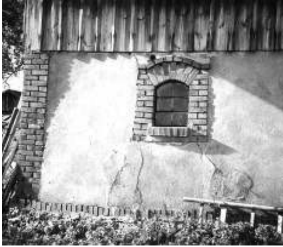
XX a. pirmajai pusei būdingas molinis tvartas Vilkyčių apylinkėse: tinkuotos molinės sienos, raudonų plytų apvadai aplink angas, iš raudonų plytų išmūryti pastato kampai ir pamato apačia, medinis ertikis // Martyno Purvino nuotr. (1996 m.)
