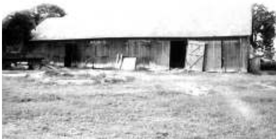
XX a. pirmajai pusei būdinga didžioji daržinė Šilutės apylinkėse – medinė rėminė konstrukcija, išorėje apkalta stačiomis lentomis // Martyno Purvino nuotr. (1994 m.)
